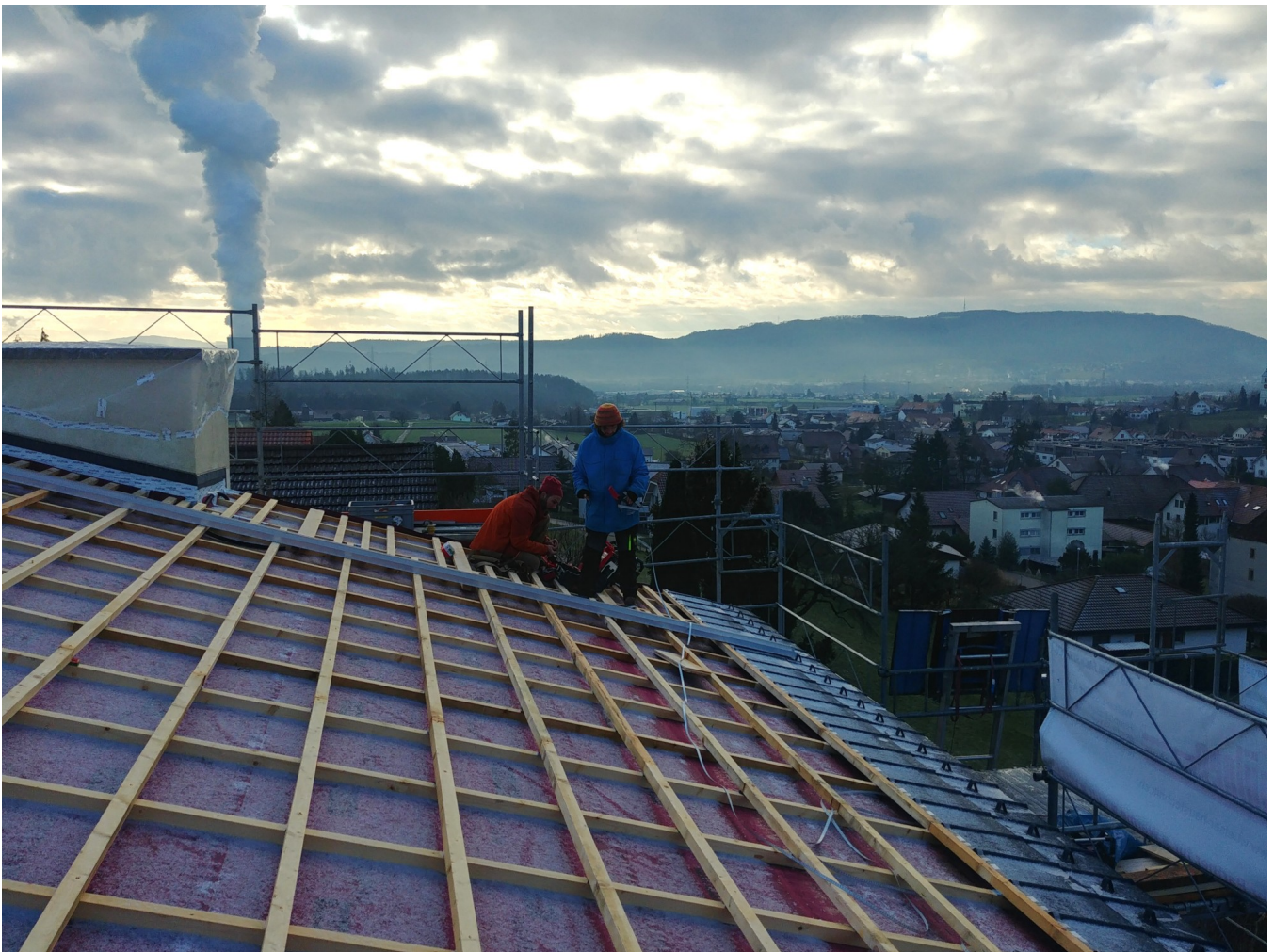
Abbildung 9: Auch im Winter bei klirrender Kälte wurden Solaranlagen montiert.
