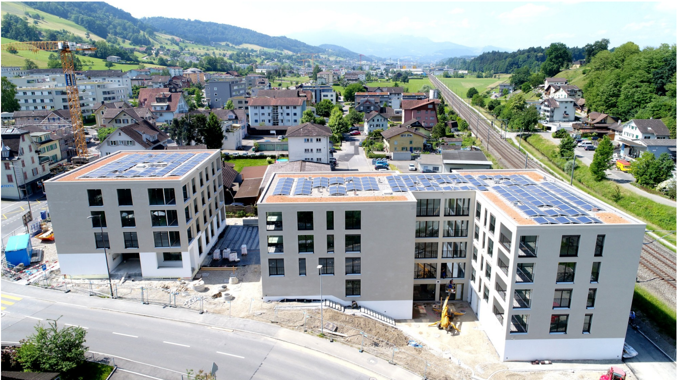
Abbildung 6: Eigenverbrauchsgemeinschaft Neubau Rösli in Root LU
