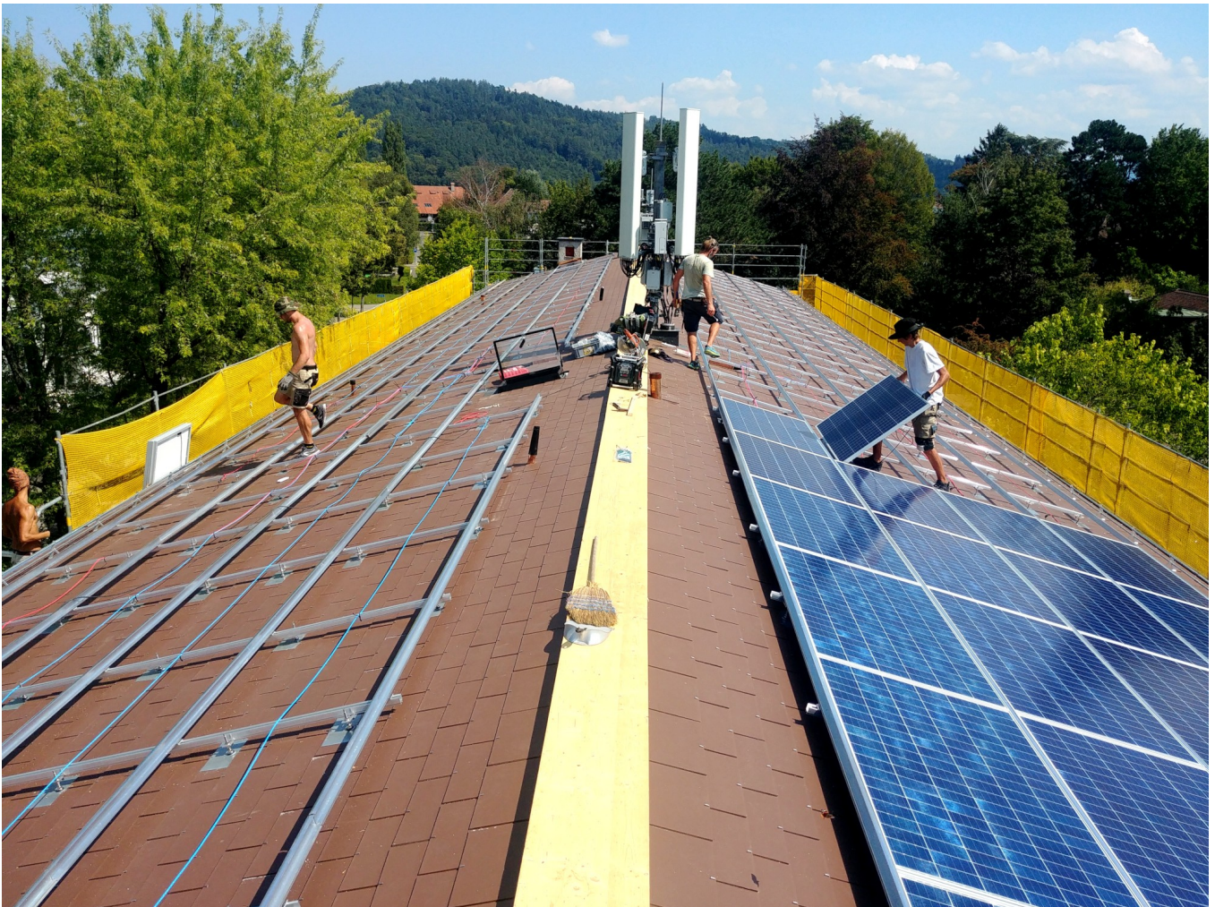
Abbildung 3: Montage einer Photovoltaik-Anlage für den Kanton Bern.
